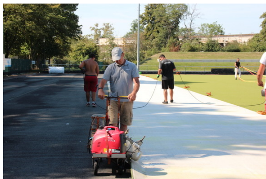
Letzte Arbeiten am Belag
